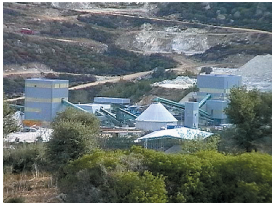
Bild 2: Die Aufbereitungsanlage Orani am Fuße des Tagebaus Fig. 2: The Orani processing plant at the foot of the open pit
